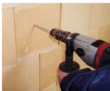
Bohrmaschine ohne Schlagwerk verwenden.
