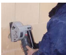
Mit der Schlitzfräse die Ziegel schlitzzen.
