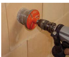
Bohrmaschine mit Bohrkronen verwenden.
