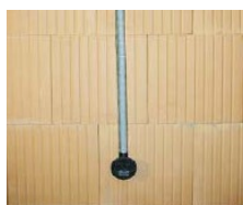
Verlegung der Elektroinstallationen.
