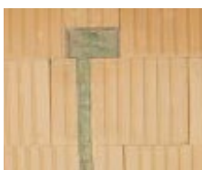
Freischlagen der gesägten/geschlitzten Bereiche mit Hammer & Meißel.
