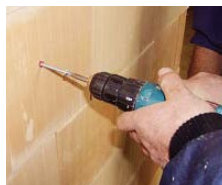
Schraube in den Dübel eindrehen.
