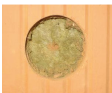
Elektrodose anzeichnen und bohren.
