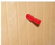
Dübel setzen.
