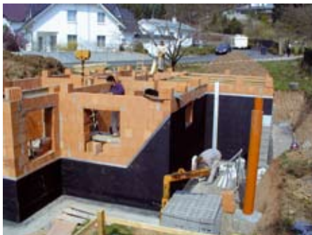
Abdichtung mit selbstklebenden EPDM-Dichtungsbahnen
