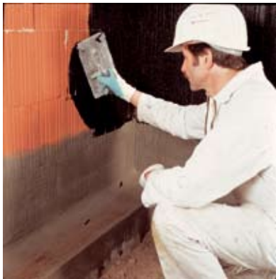
Foto: Remmers Bauchemie Aufbringen einer Abdichtung mit Bitumen-Dickbeschichtung
