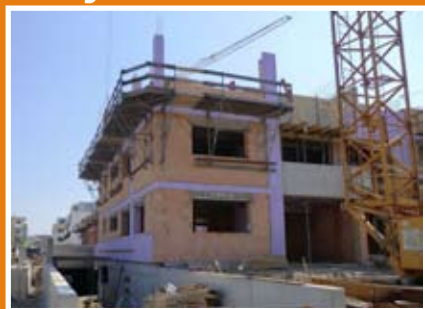
Bau einer Wohnanlage in Ulm mit MZ10
