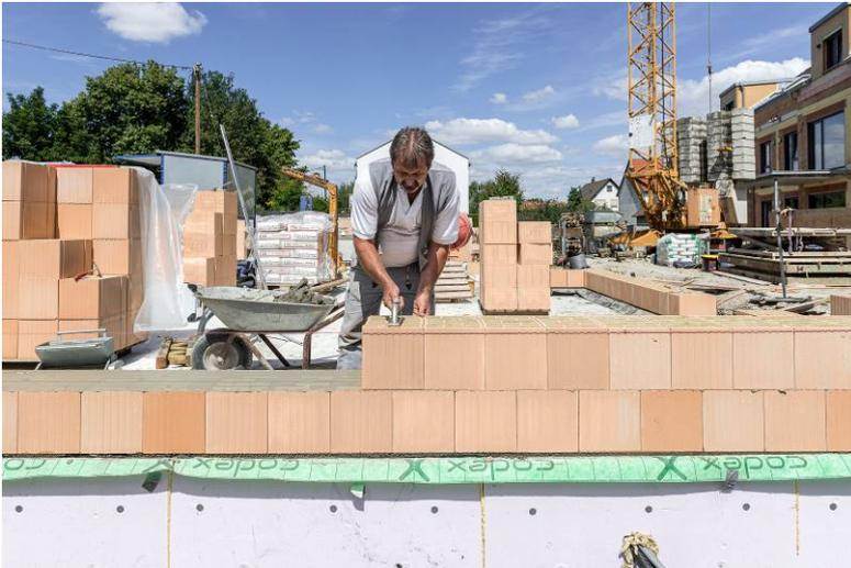
BU: Der MZ75-G wird samt der Ergänzungsziegel für Außenecken, Fensterlaibungen, Pfeilermauerwerk sowie zum Höhenausgleich von Raumhöhen und Fensterlaibungen schnell und einfach im Dünnbettmörtelverfahren verarbeitet.
