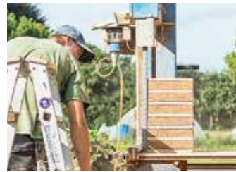
23 Und so sieht der zurechtgesägte Stein von der Seite aus. Zu erkennen die offenen, gefüllten Kammern.
