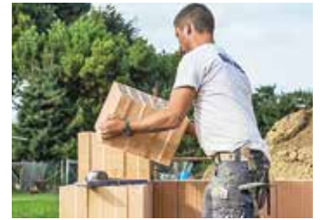
28 Trotz Automatisierung und serieller Bauweisen bleibt das Bauen mit Ziegeln Handarbeit.
