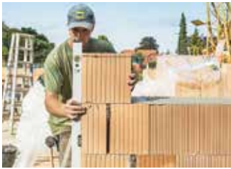
25 Alles „im Wasser“? Die teilvermörtelte Fuge in der Bildmitte ist etwas breit geraten.
