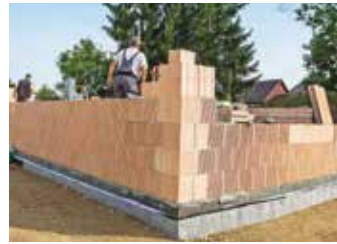
26 Inzwischen sind die Maurerarbeiten fortgeschritten, das Haus nimmt allmählich Gestalt an.
