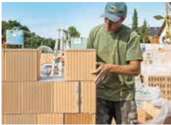
21 Nachdem bei diesem Abschnitt der Endstein gesetzt ist, braucht es einen Stein im Sonderformat.
