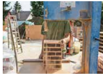
22 Den Stein mit Spezialabmessungen stellt der Handwerker mithilfe der Säge selbst her.
