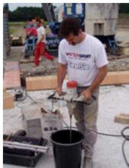
2. Dünnbettmörtel aus dem Eimer in die Walze leeren. Vor Gebrauch Mörtelkontaktflächen der Walze (außer Mörteltransportwalze) mit Trennmittel (Öl) behandeln.
