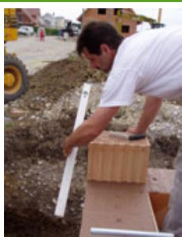
6. Ecksteine mit Dünnbettmörtel links und rechts anspatzen und gegen die glatte Ziegelseite setzen.
