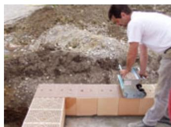
5. Die Länge des aufgetragenen Frischmörtels richtet sich maßgeblich nach den Witterungsbedingungen. Die Ziegel werden in den Frischmörtel gesetzt.
