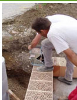
4. Walze in Pfeilrichtung bewegen (beide Laufrollen auf den Ziegel drücken). Die Walze besitzt einen Längsanschlag, um ein genaues Aufwalzen zu ermöglichen.
