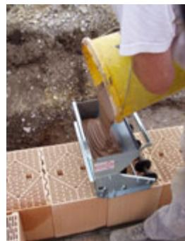
3. Aufsetzen der Walze am Mauerwerk (Die Walze muss bis zur Abwinkelung überstehen).
