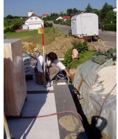
Ermittlung des höchsten Punkt der Decke. Aufbau und Ausrichtung des Justierboy (Laser), Laserlatte auf Höhe ausrichten.
