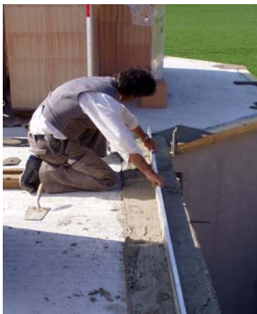
Aufgetragener Mörtel mit Alu- latte abziehen
