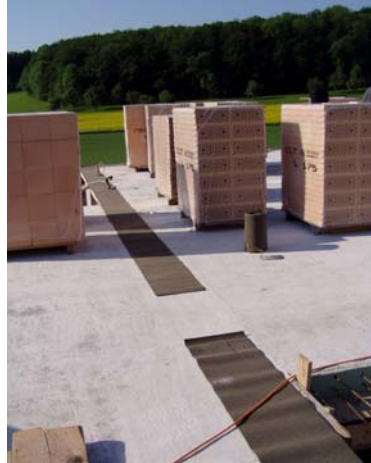
Auslegen der Dachpappe Auf der Rohdecke
