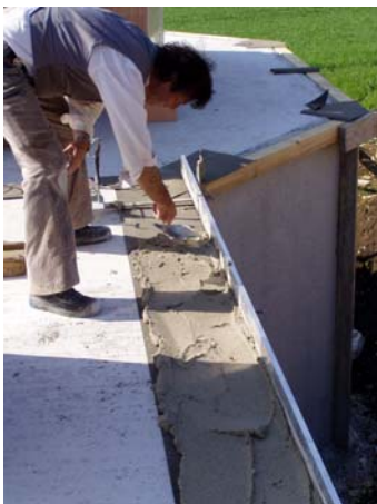
Mörtel mit Schaufel & Mörtelkelle auftragen
