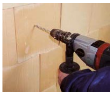
Bohrmaschine ohne Schlagwerk verwenden.
