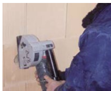
Mit der Schlitzfräse die Ziegel schlitzzen.
