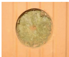
Elektrodose anzeichnen und bohren.
