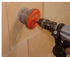
Bohrmaschine mit Bohrkronen verwenden.
