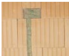
Freischlagen der gesägten/geschlitzten Bereiche mit Hammer & Meißel.
