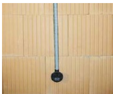
Verlegung der Elektroinstallationen.
