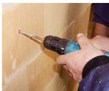
Schraube in den Dübel eindrehen.
