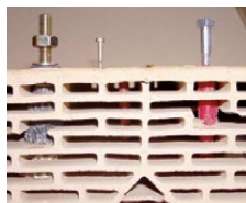
Tipp Bei gebrochenen Innenstegen durch falsches Bohren (z. B. Schlagbohren) sollten Injektionsdübel verwendet werden.
