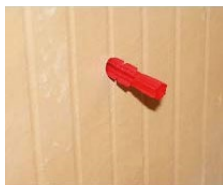
Dübel setzen.
